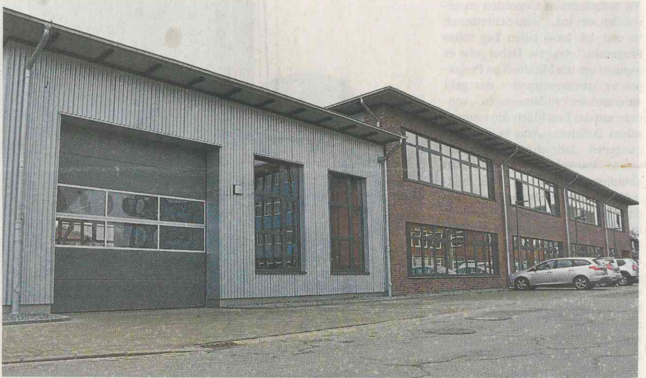
Der Neubau mit der Werkstatt: Der Kreis hat das Gebäude für die Metallberufe am BBZ-Standort Meldorf neu errichten lassen.
